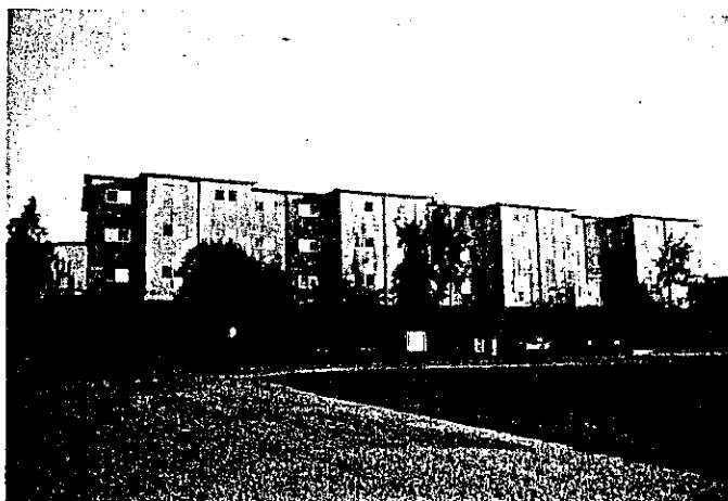
BLDG. 1463, BEQ - BEQ AREA
