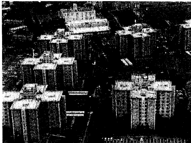
横田基地内の高層住宅（建設費1棟2.3億円）
