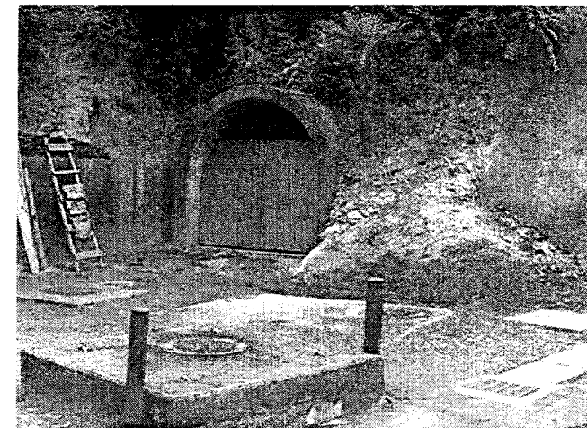
田浦配水場坑道入口
