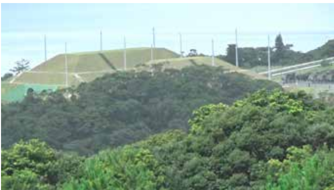
奄美駐屯地の巨大な弾薬庫。避雷針が何本も立っている。右側の車輛は、ミサイル運搬車輛。瀬戸内駐屯地の弾薬庫はトンネル式でさらに巨大である。
